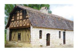
Le pan de bois : Mêlant ossature en bois et remplissage en torchis ou en pierres, recouverte d'un enduit, cette techniquese retrouve sur de nombreuses maisons situées sur la commune de Ste Radegonde tel qu'à Issigeac.
